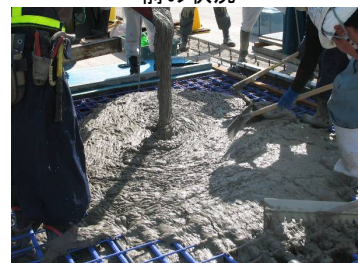
写真-4 打込みの状況
