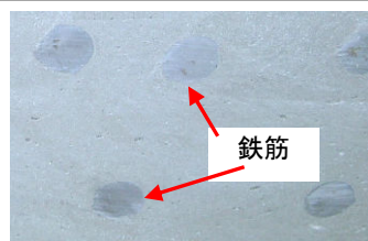
写真-2 鉄筋周りの充てん状況
