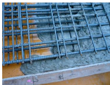
写真-1 模擬試験体の型枠内における流動状況
