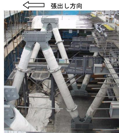
写真-2 トラス材設置状況
