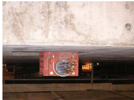
写真-3 後方ケーブル固定治具
