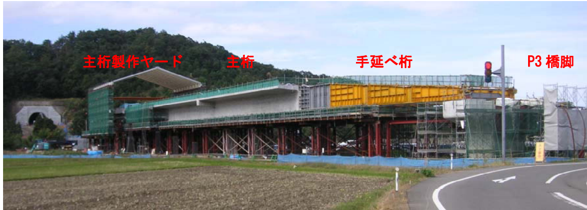
写真-1 道路上押し出し前状況
