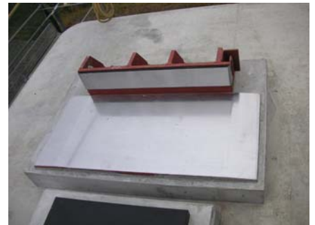
写真-4 鋼製すべり支承
