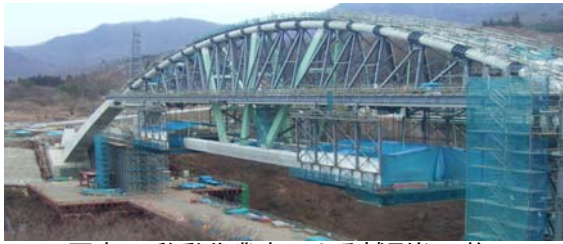
写真-4 移動作業車による補剛桁の施工
