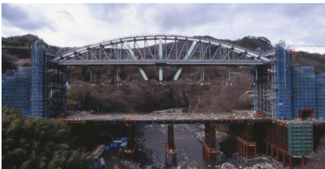
写真-3 アーチリブ+アーチタイ リフトアップ2回目
