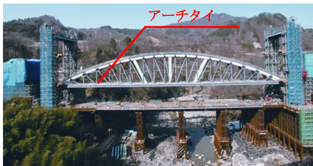
写真-2 アーチリブ+アーチタイ リフトアップ1回目
