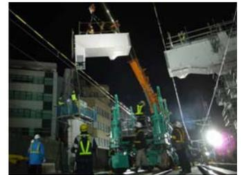
図6 鉄骨架設状況
