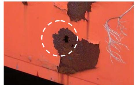
腐食による劣化が進行し穴が空いている
