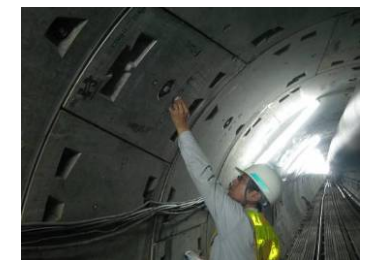
写真-2 ICタグの取付状況
