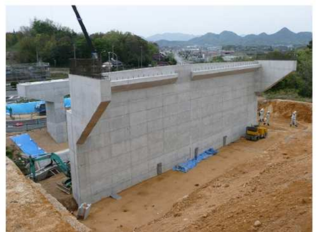
図2 ひび割れ抑制対策を講じて有害なひび割れ抑制した25m幅の橋台
