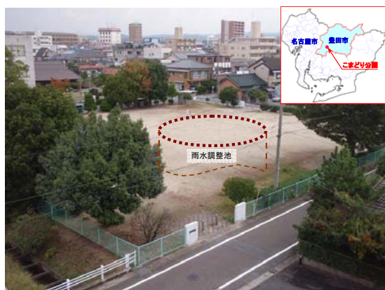
図-2 着工前状況
