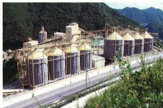
写真-1 骨材製造設備全景
