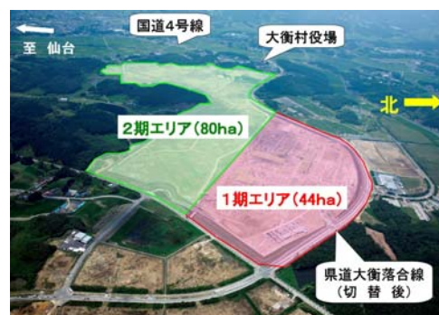
写真-1 現場全景
