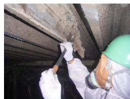
写真-1 石綿除去状況
