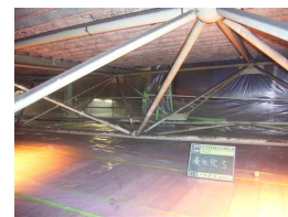
写真-2 養生完了状況
