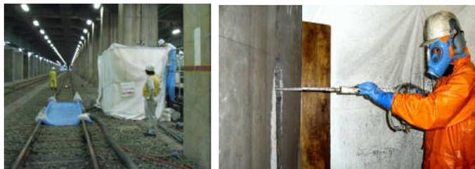
ウォータージェット工法によりコンクリートを破碎し切り取るために必要な超高圧水圧能力は、240Mpa、350/分である。濁水処理プラントは、10m<sup>3</sup>/h、25ppm 以下で柱周りの各釜場から水中ポンプにより循環し場外プラントまで吸い上げ処理することとした。
