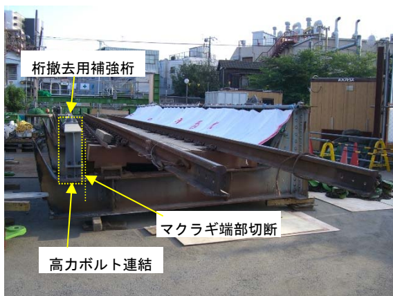
図4. 桁撤去用補強桁（桁撤去後）
