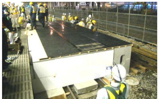
写真-1 試験施工時の状況
