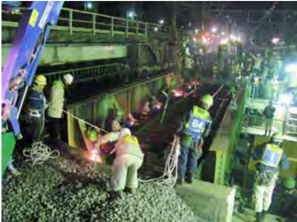
写真-2 横桁上部の切断状況
