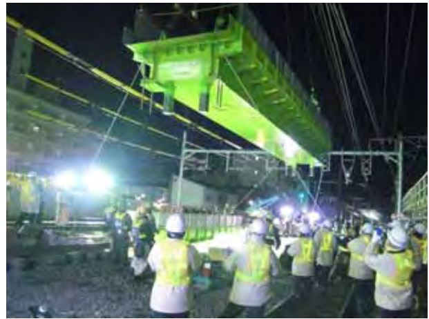
写真-3 新桁架設状況
