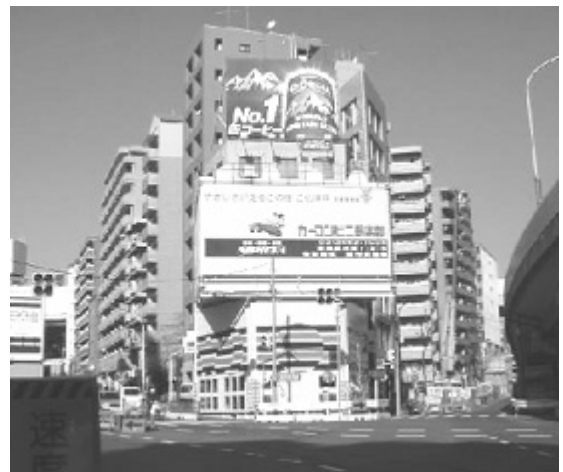
写真-1 防音ハウス
