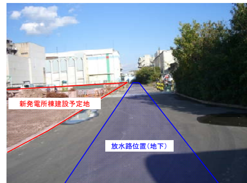
写真1 現地状況(工事着手前)
