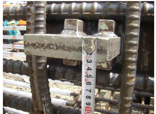
写真-2 吊ピース
