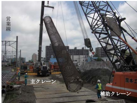
写真-1 鉄筋かご吊込み状況
