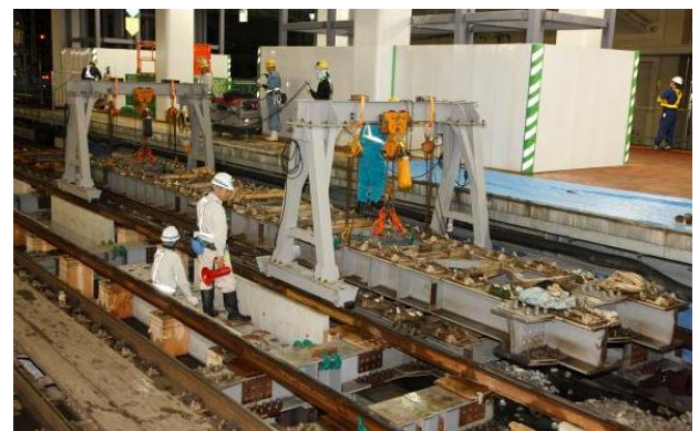
図 5 工事桁撤去状況
