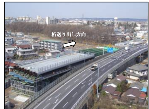
写真-1 桁送り出し前(鋼製地覆・防護柵・添架管施工済み)
