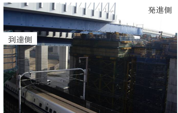
図－5 下り線送出し後写真
