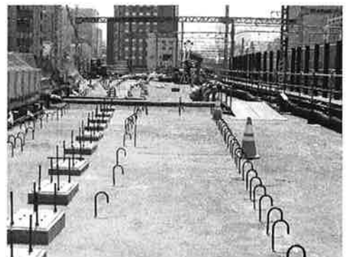
写真-2 アンカー打設完了状況
