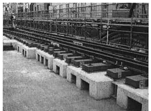
写真-3 完成した直結軌道
