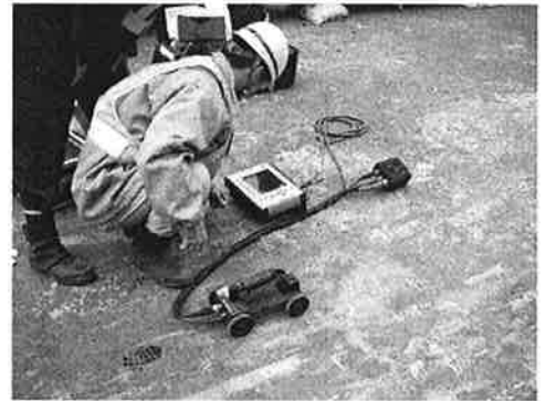
写真-1 鉄筋探査の実施状況
