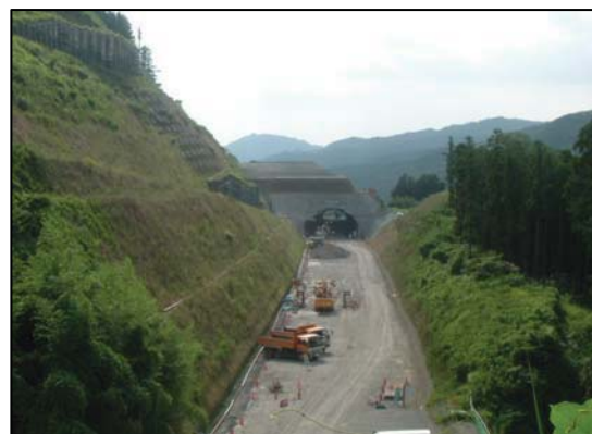
写真-1 明り巻き区間施工位置
