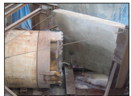
写真-7 掘進終了
