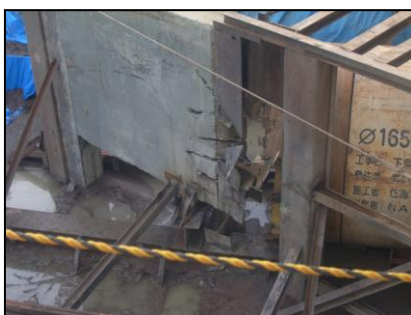
写真-5 掘進状況
