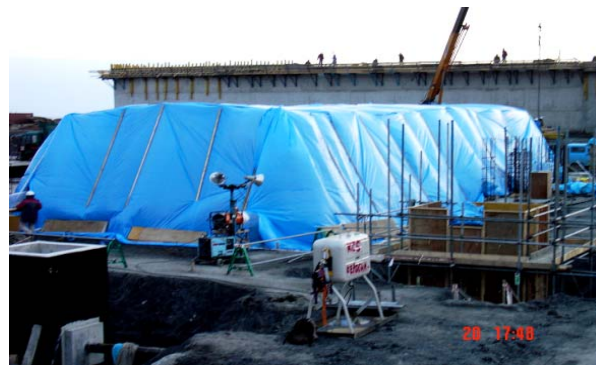
図-3.1 コンクリート養生用シェルター
