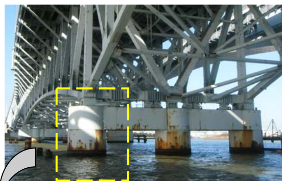
写真-1 荒川湾岸橋 橋脚現況写真
