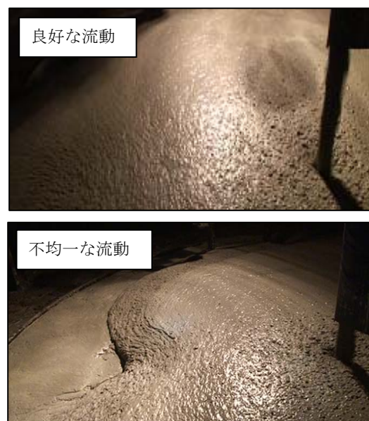
写真-2 ダイヤフラム周辺の充てん状況
