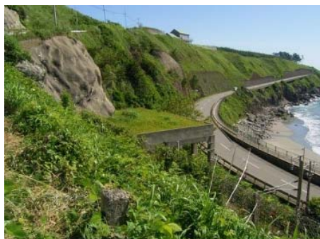
写真1 落石覆い全景
