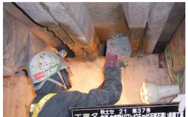
写真3 防錆剤塗布状況
