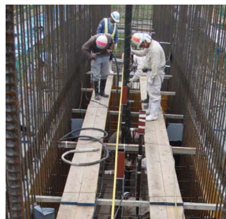
写真-2 コンクリート打込み状況
