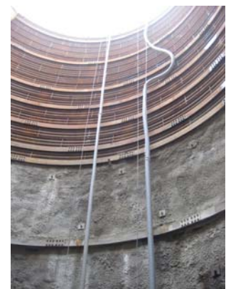
写真-6 補強工完了
