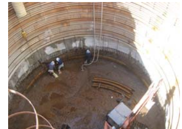
写真-5 施工状況
