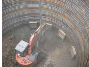
写真-2 吹付け状況
