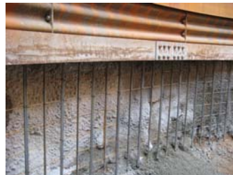
写真-4 配筋状況
