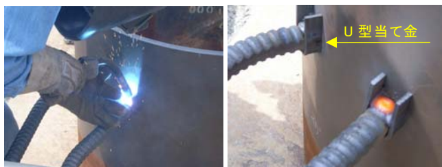
写真-2 マグ溶接状況
