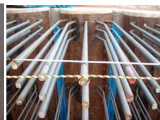
写真-5 マグ溶接完了
