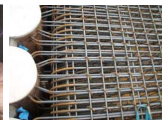
写真-8 結合鉄筋組立完了
