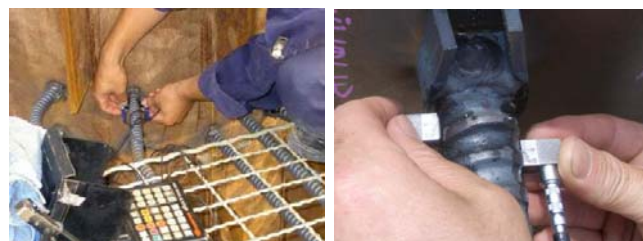
写真-6 超音波探傷検査状況
