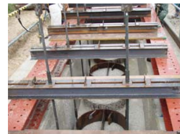
写真-5 高さ調整状況
