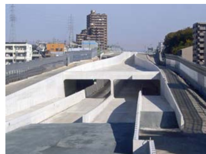
写真-1 掘割構造
