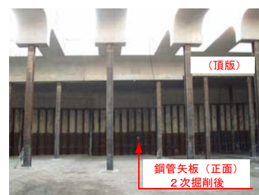
写真-6 鋼管矢板施工完了
