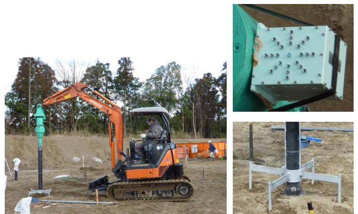
図 - 3 施工機・傾斜管理装置・杭芯固定治具
