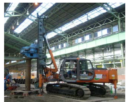
図-5 回転杭施工状況
