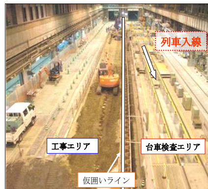
図-2 近接作業状況
