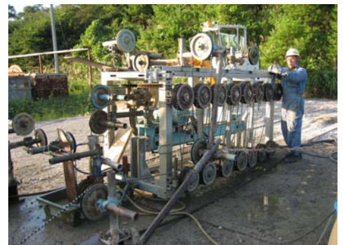
写真-1 長距離対応型地盤切削装置
