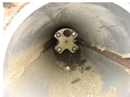
写真-4 切削土砂の堆積状況（ガイドパイプ内）
