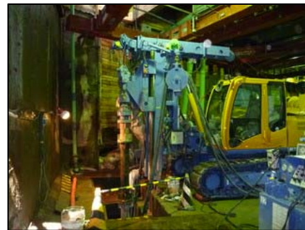
写真-2.路下連壁施工状況
