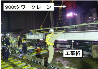
写真－1 工事桁架設状況
