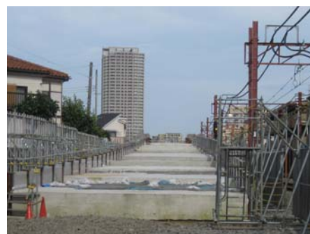
写真-3 気泡モルタル打設完了
