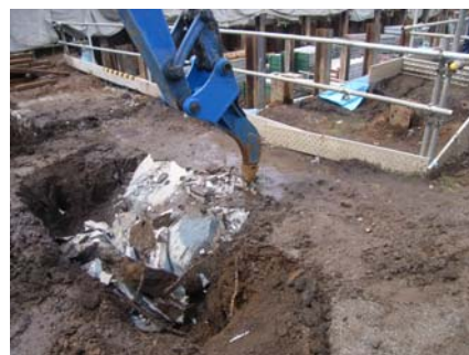
写真-1 撤去性確認試験状況
