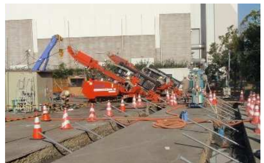
写真-2 削孔・注入管設置状況
