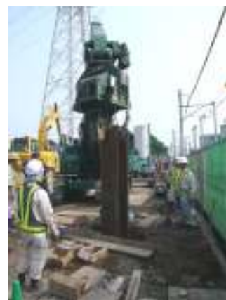
写真-2 H形鋼挿入状況
