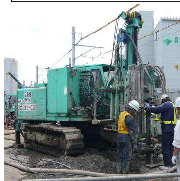
写真-1 使用施工機械
