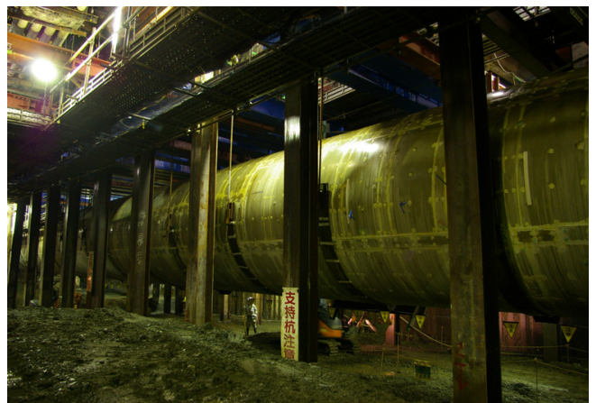
図5 吊防護状況写真
