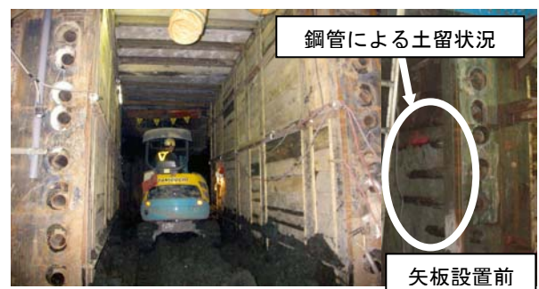
写真－3 導坑掘削状況
