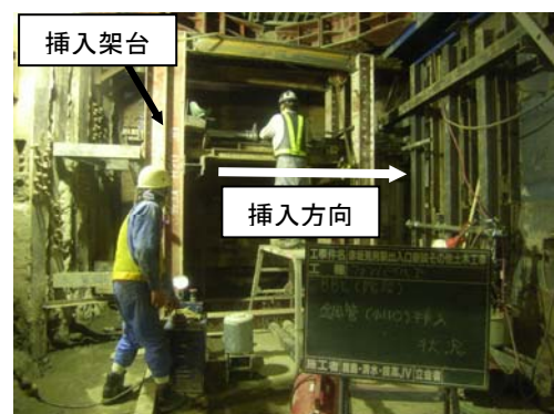
写真－2 鋼管圧入状況
