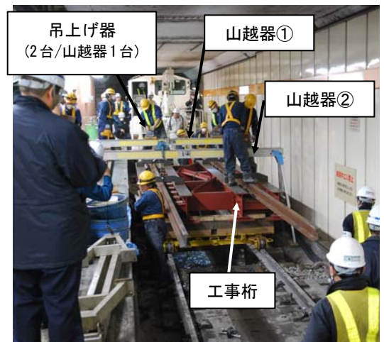
写真－1 工事桁架設状況
