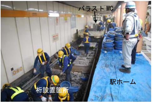
写真－1 バラスト撤去状況写真
