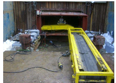
写真 2 薄型ベルコンを設置した状態
