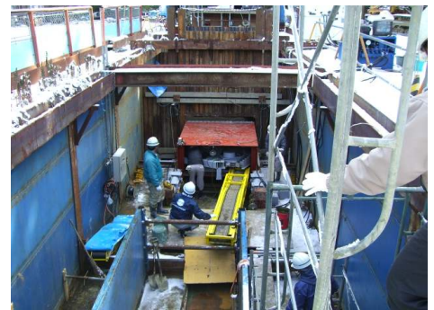
写真 1 模擬地山の試験施工
