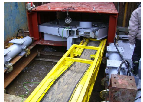
写真 3 横型ギャザリングを設置した状態
