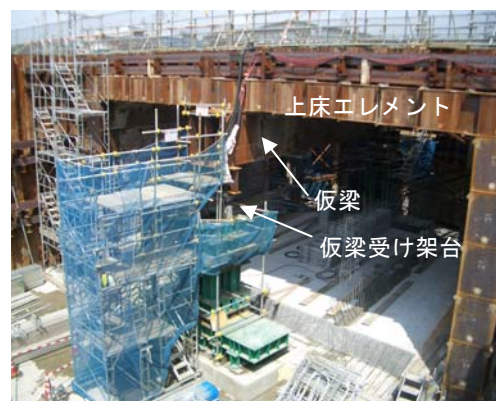
図-4 施工状況写真 (内部掘削完了)
