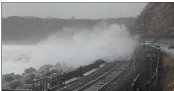
写真-1 越波状況
