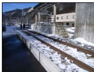
図-3 空洞探査設備
