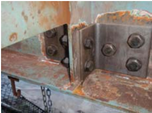
写真 - 2 当て板設置
